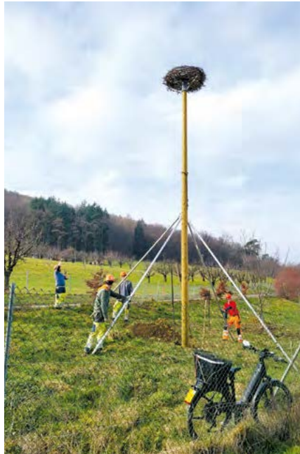
Das EBL- Freileitungsteam stellt die Horststangen auf.
