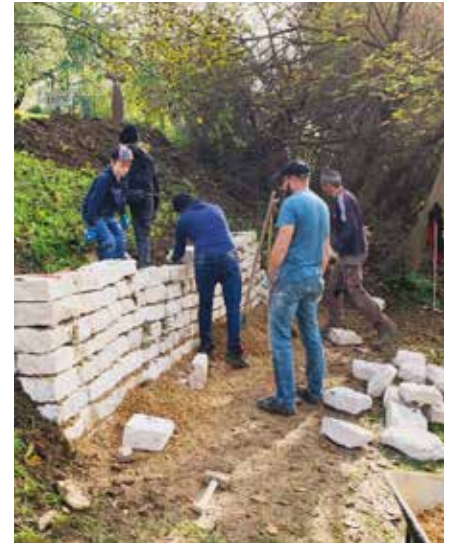
AGNH Sissach: In Zusammenarbeit mit EWG im Griederland Bau einer Trockenmauer
